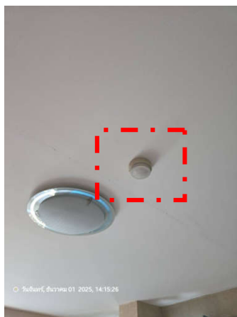
อุปกรณ์ตรวจจับความร้อน (Heat Detector)
