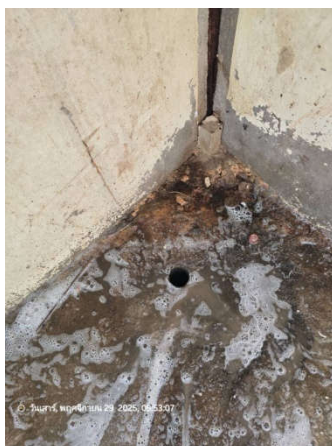
รูปที่ 2-18 ท่อรวบรวมน้ำจากการล้าง ห้องพักมูลฝอยรวม
